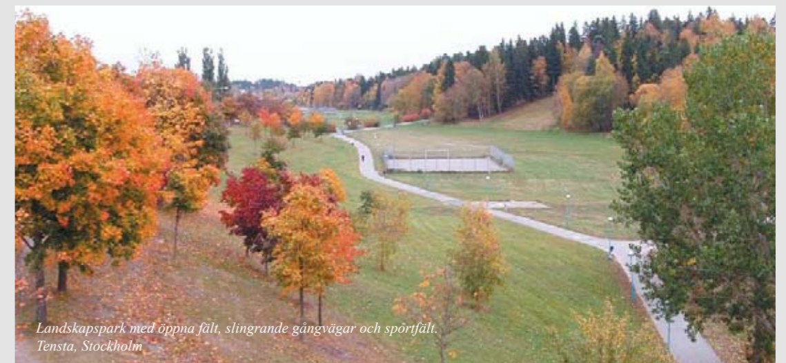
Exempel på småhusbebyggelse i kuperad terräng, varsamt inpassad i naturen. Östra kvarnsåsen, Sollentuna, arkitekt Brunnberg och Forsked, 2006
