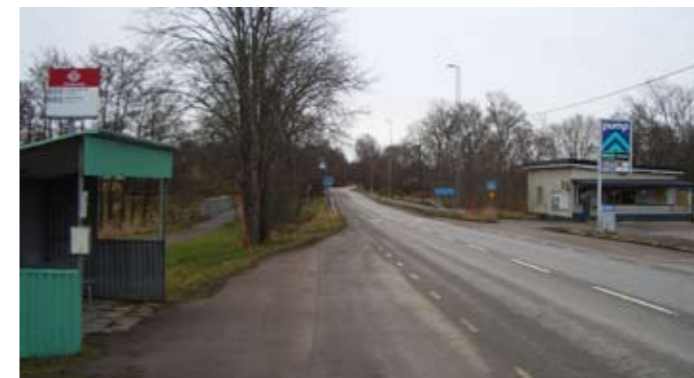
Befintlig busshållplats i Brottbys.
