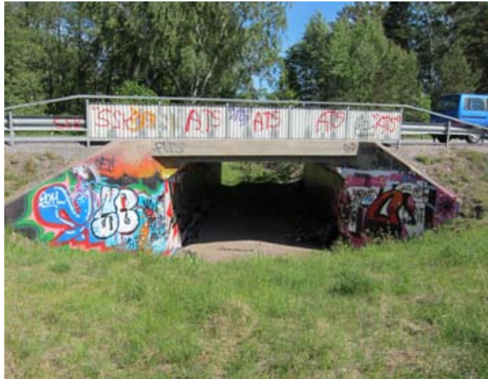
Befintlig oanvänd vägport under E18
